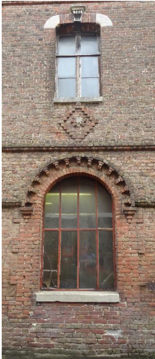
Détail des baies de l'atelier de fabrication.
