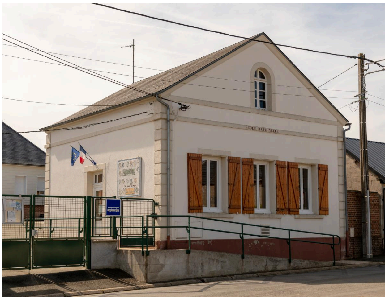
École maternelle, rue de la Ville, vue depuis le nord-ouest.
