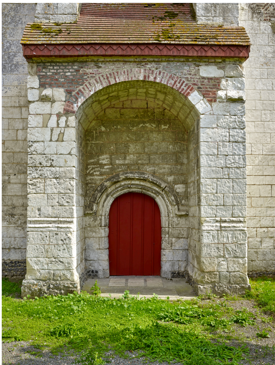
Détail du porche, depuis l'ouest.
