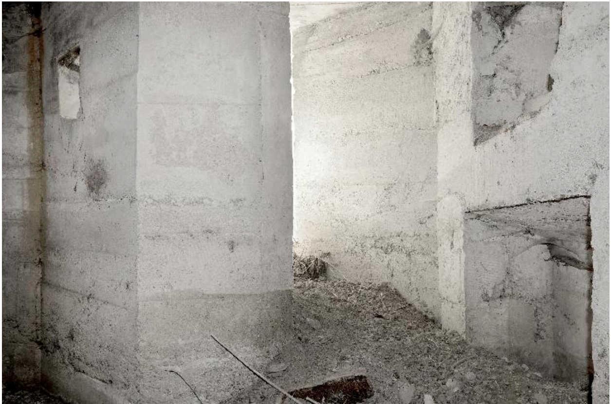
Entrée sud, le créneau de fusillade, à gauche
