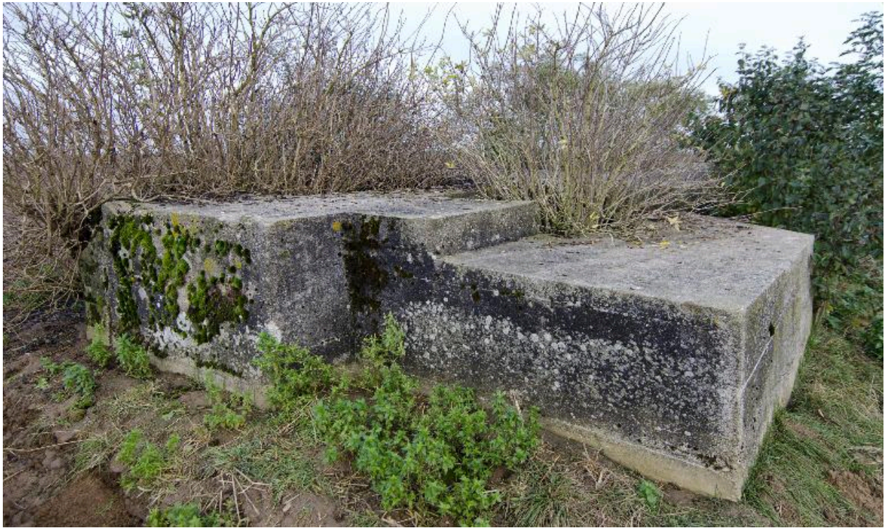
Angle sud-ouest vers l'est. La partie droite abrite l'observatoire cuirassé nord
