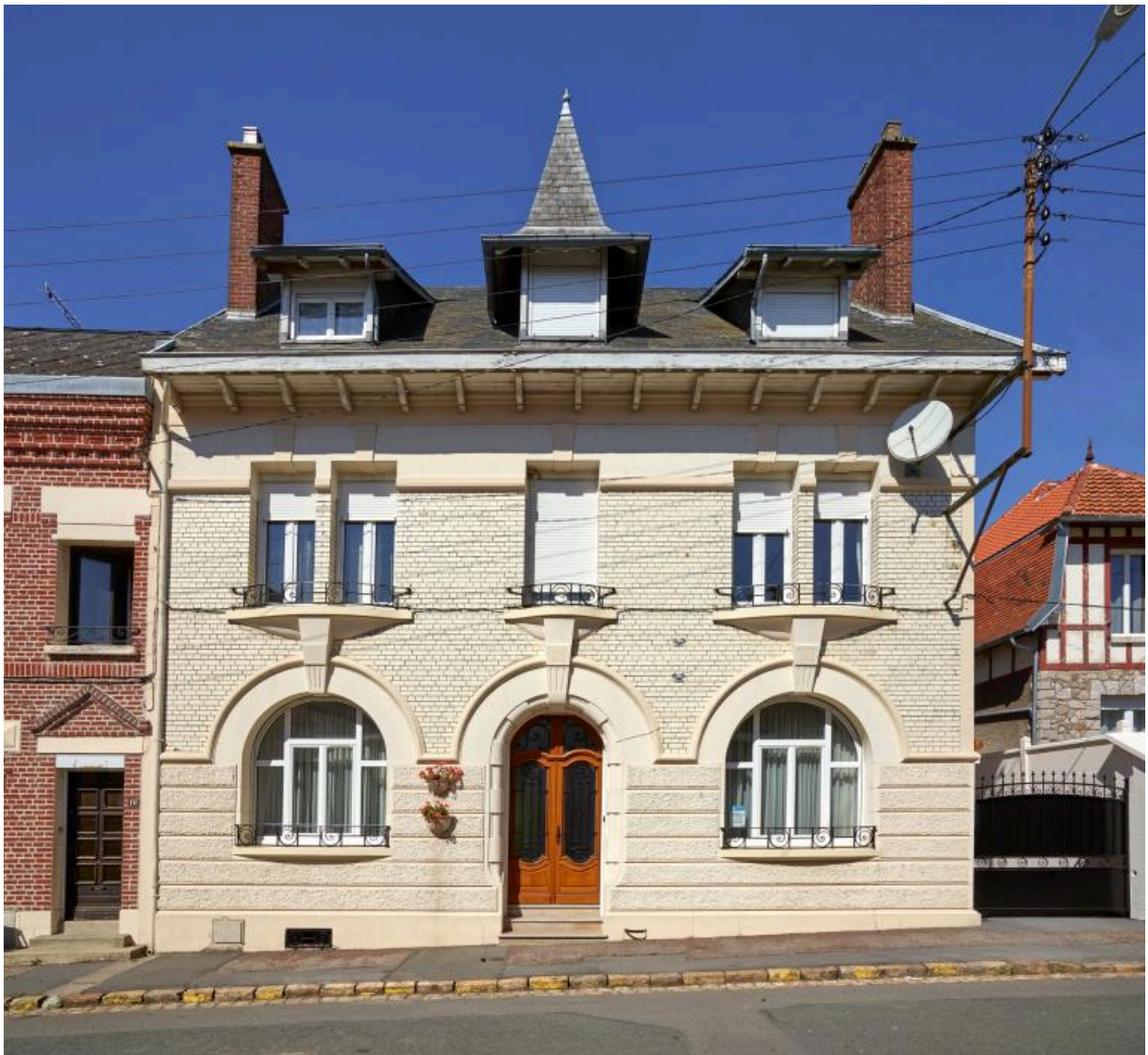
Vue générale de la façade principale.
