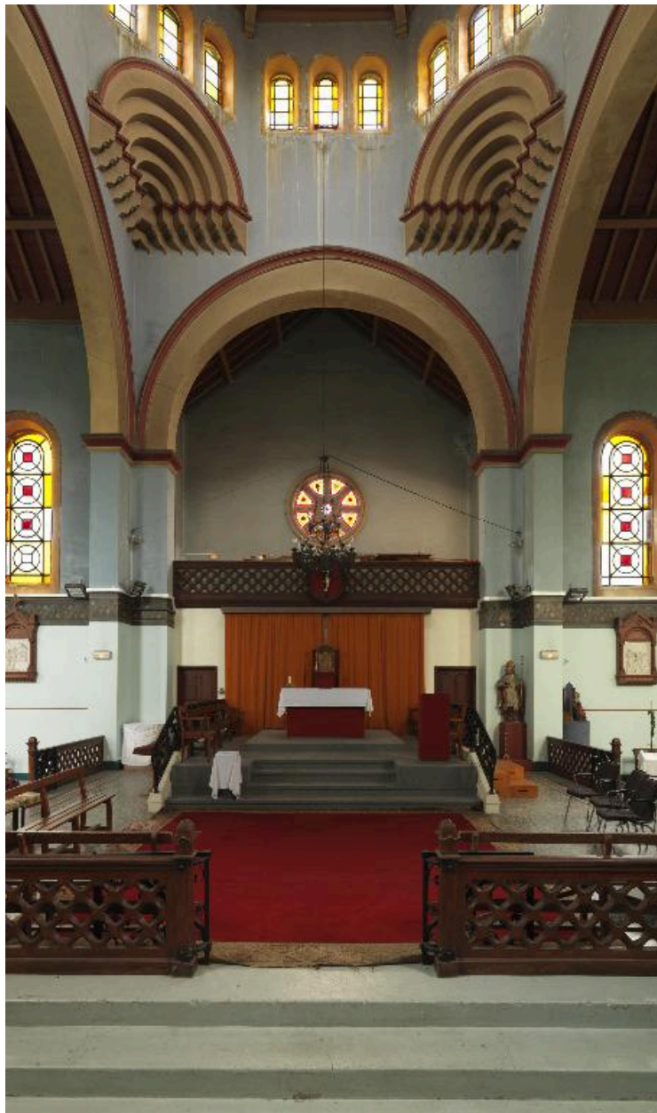
Vue intérieure vers le chœur.
