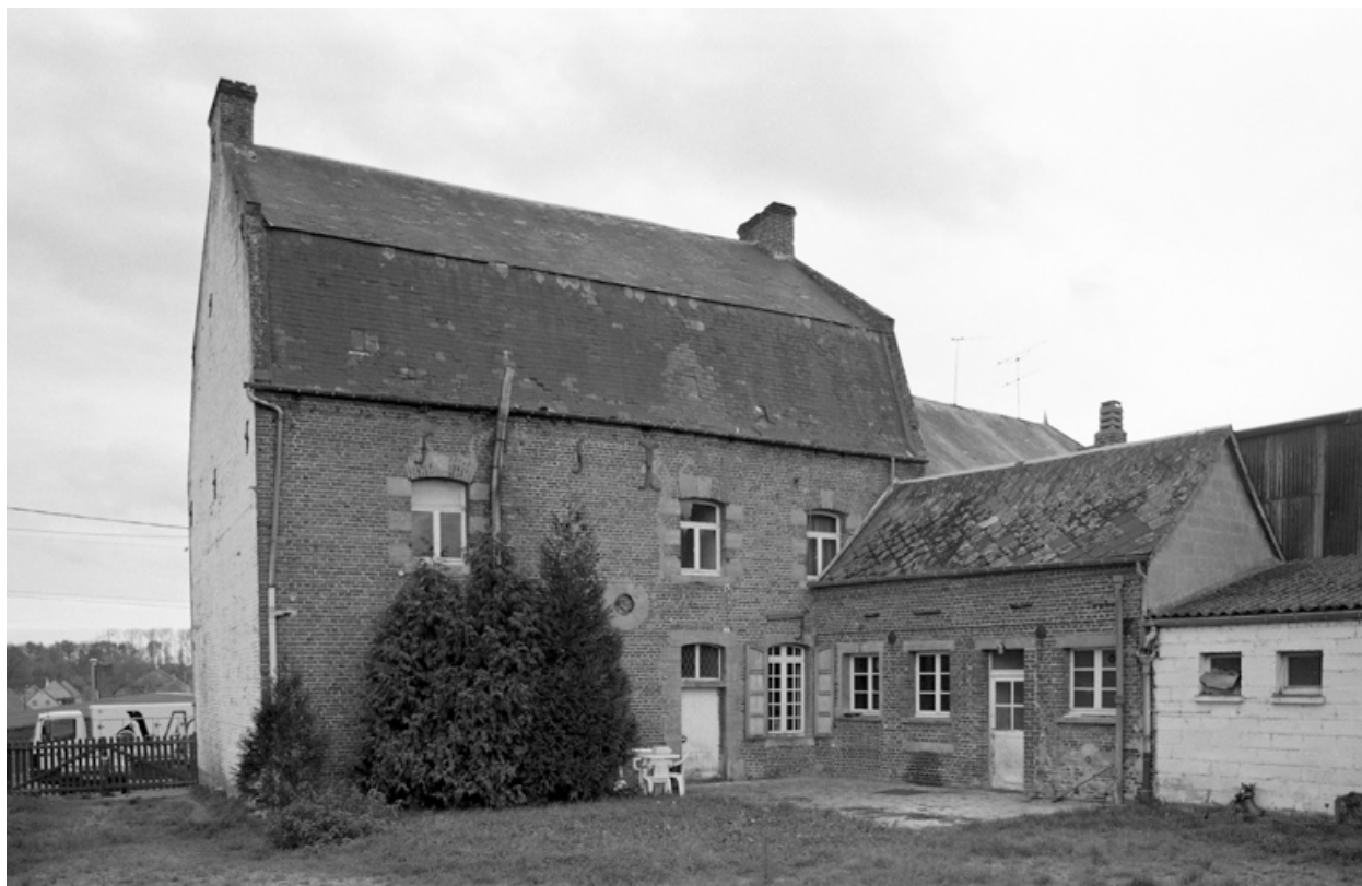
Elévation sur cour du logis.
