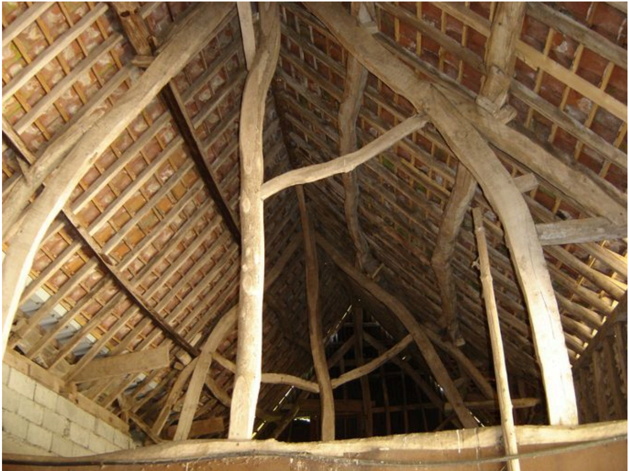
Vue de la charpente de la grange.
