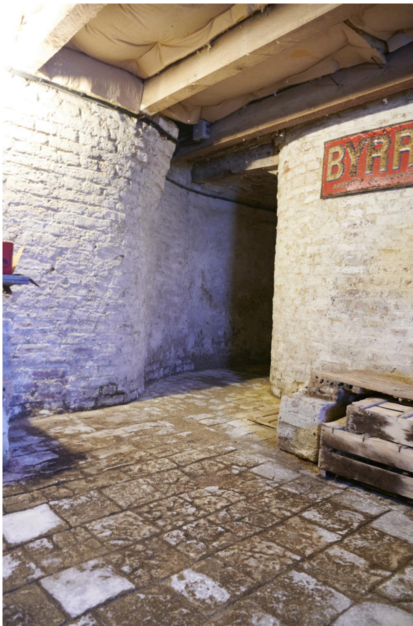
Cave de 1873. maçonnerie de brique enduit à la chaux. Sol en pierre. Corridor d'accès vers l'autre cave de 1780.
