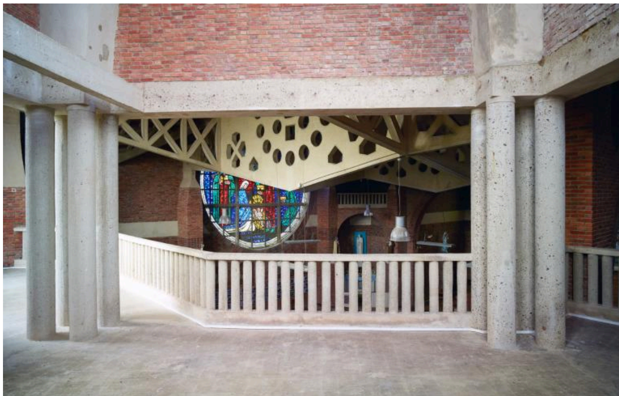
Élément de charpente depuis la tribune.
