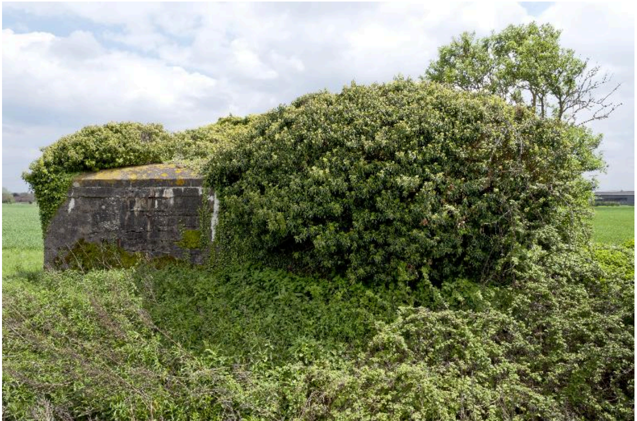
Le bâtiment B, vers le nord-est, le long du ruisseau
