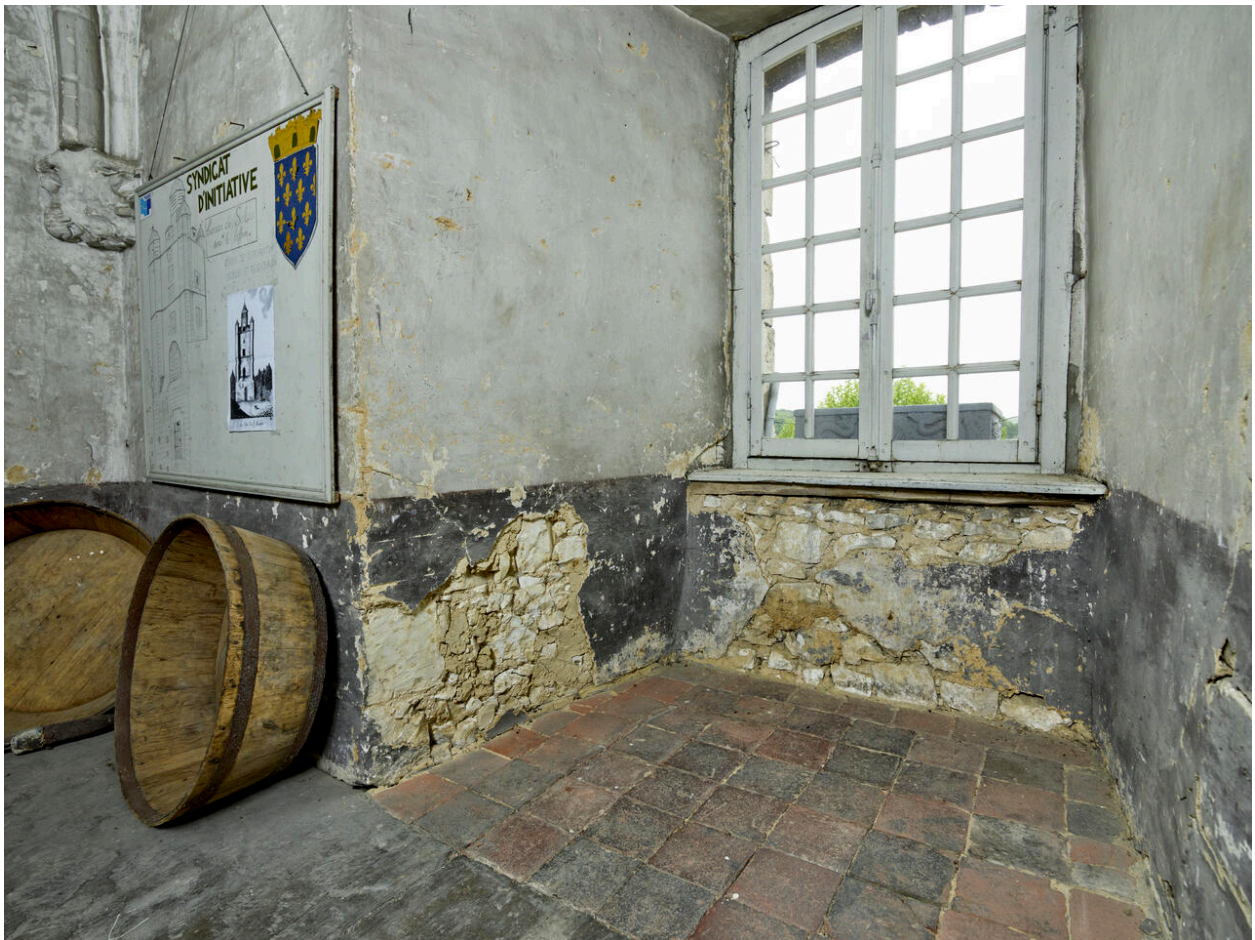
Vue de la salle du Conseil d'échevinage au premier étage du beffroi, détail du mur sud dont l'enduit est partiellement enlevé.
