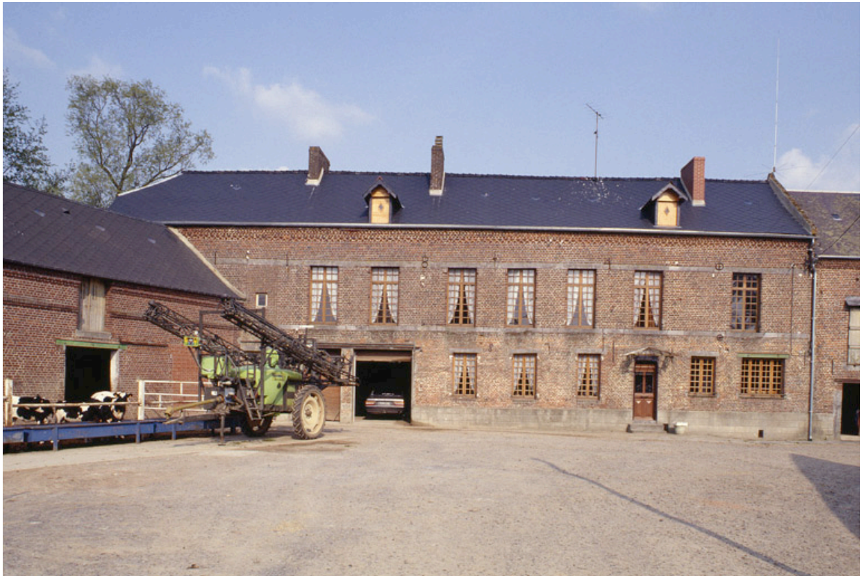
Façade du logis.
