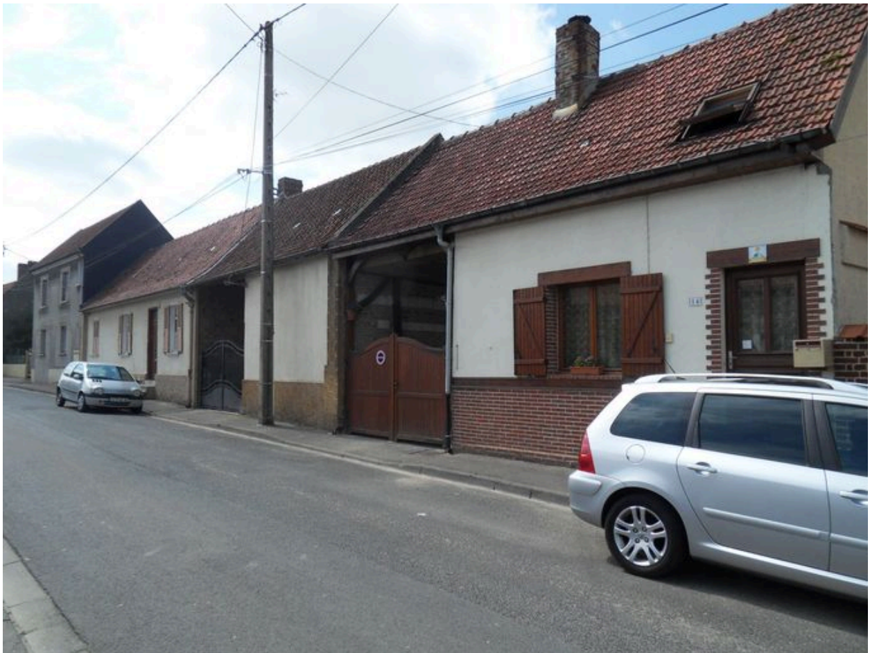
Maisons, 14 à 18 rue de Vignacourt.
