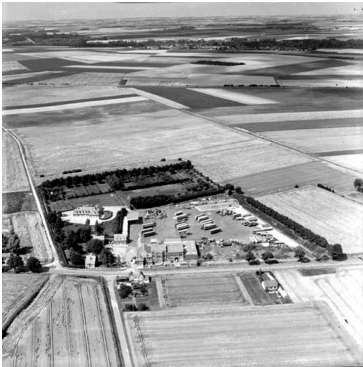
Vue aérienne, flanc sud.
