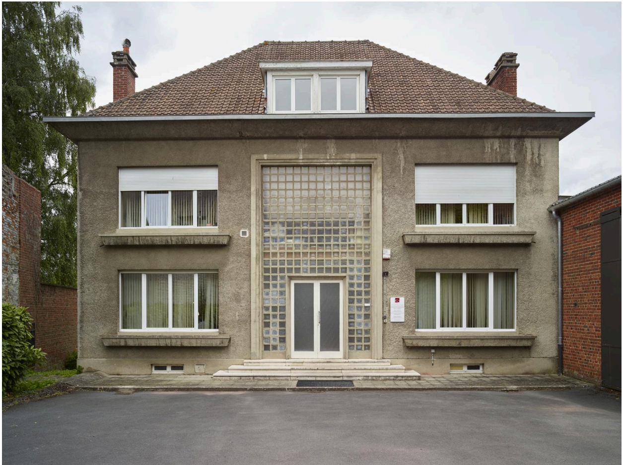
Maison, 14 rue Achille Carlier : vue générale de la façade avant.
