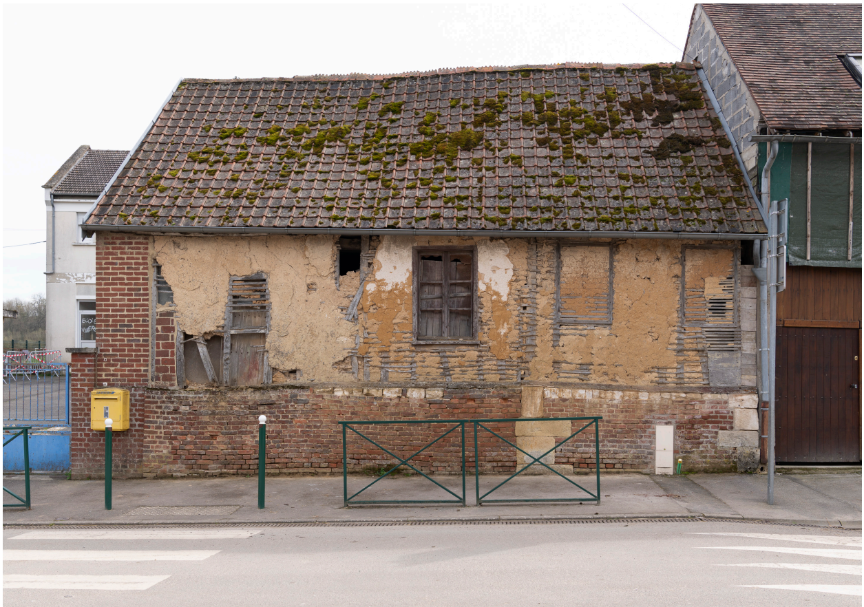
Ancien logis en pans de bois et torchis, n°6 de la rue Poncelet, vue prise depuis le nord.
