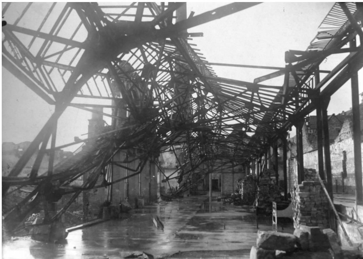
Ruines de l'atelier de peignage, 1919 (AD Aisne).
