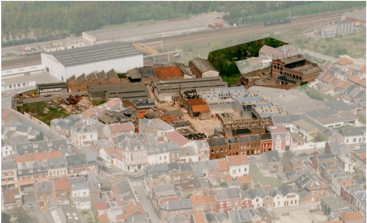
Vue aérienne vers 1989 (BM Saint-Quentin).
