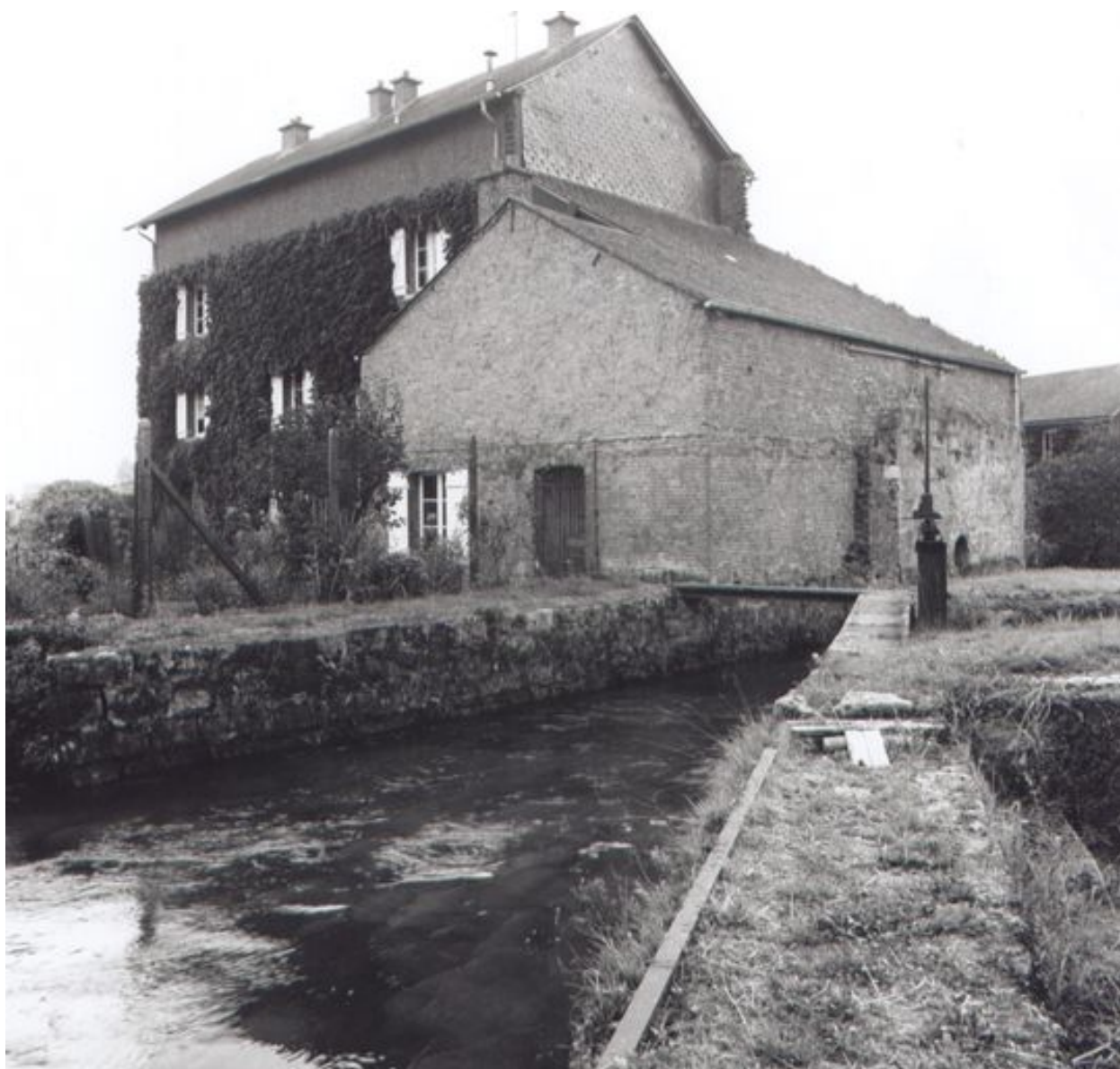
Vue d'ensemble postérieure.
