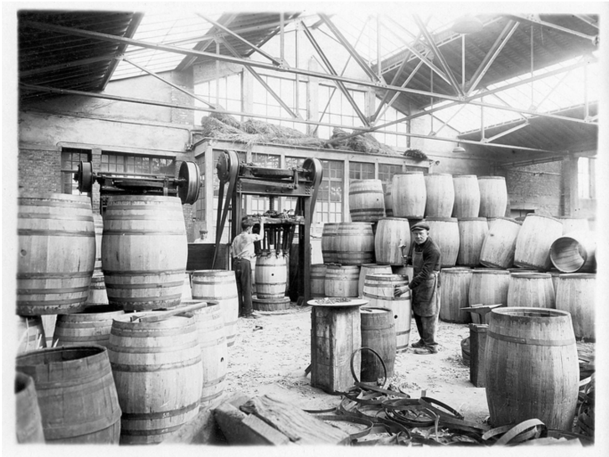
Une cercluse, 1927 (Société Fermière des Etablissements Allard - Statuts).
