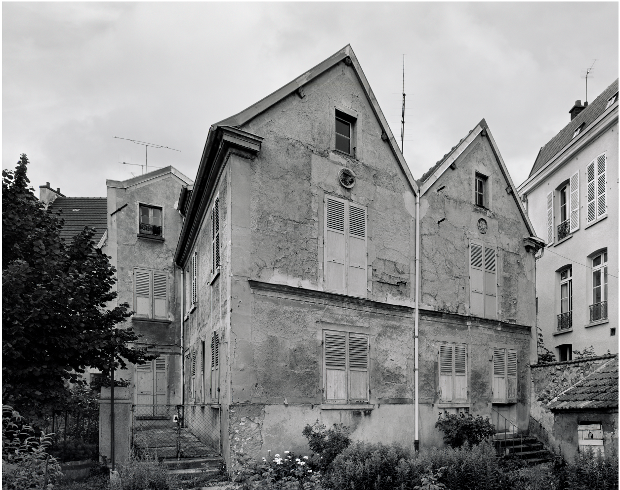
Vue des pignons sur le jardin.
