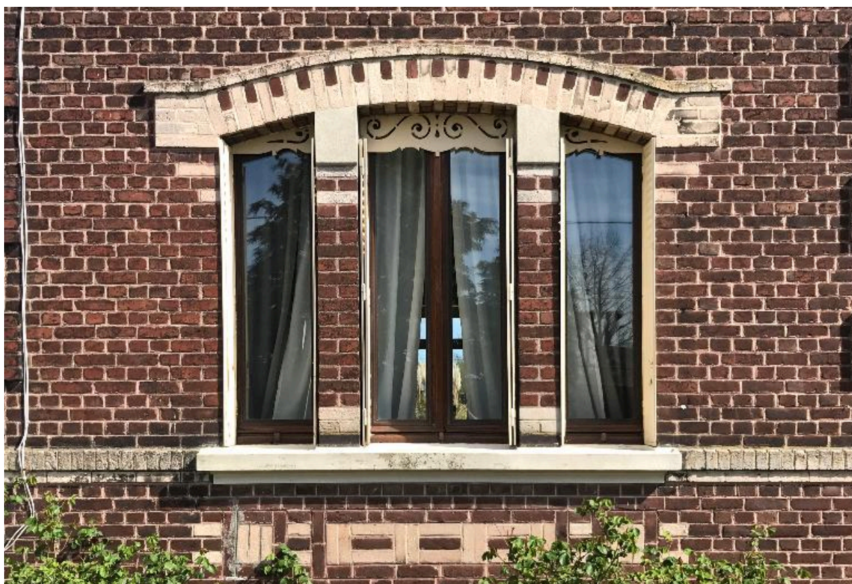
Détail d'une fenêtre en triplet.
