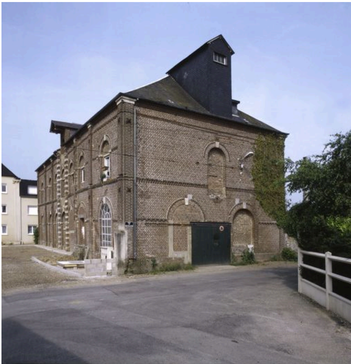
Vue d'ensemble nord-ouest de l'atelier de fabrication.
