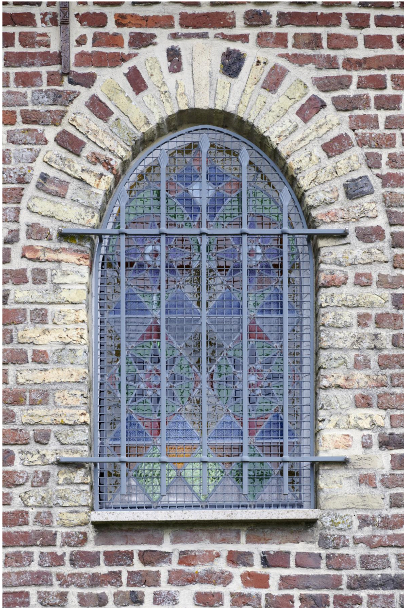
Détail de l'une des baies.
