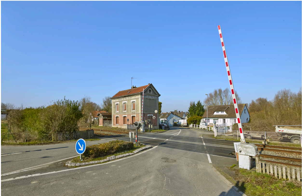
Vue de l'ancienne halte et du passage à niveau, depuis le sud-est.
