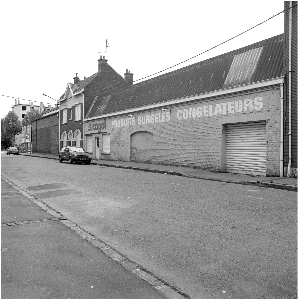
Atelier de fabrication, enfilade rue Colbert.
