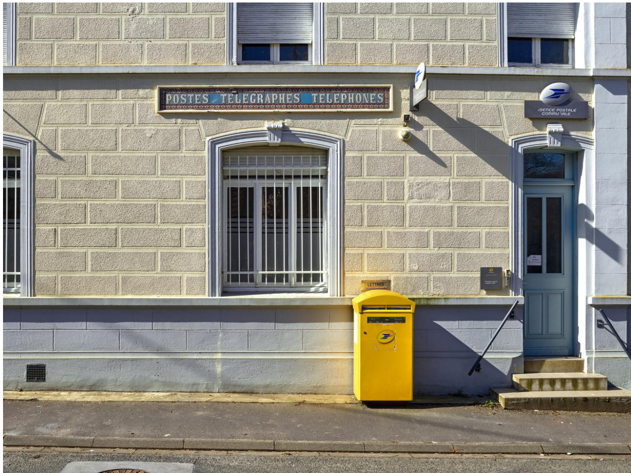
Détail de l'enseigne "Postes Télégraphes Téléphones".
