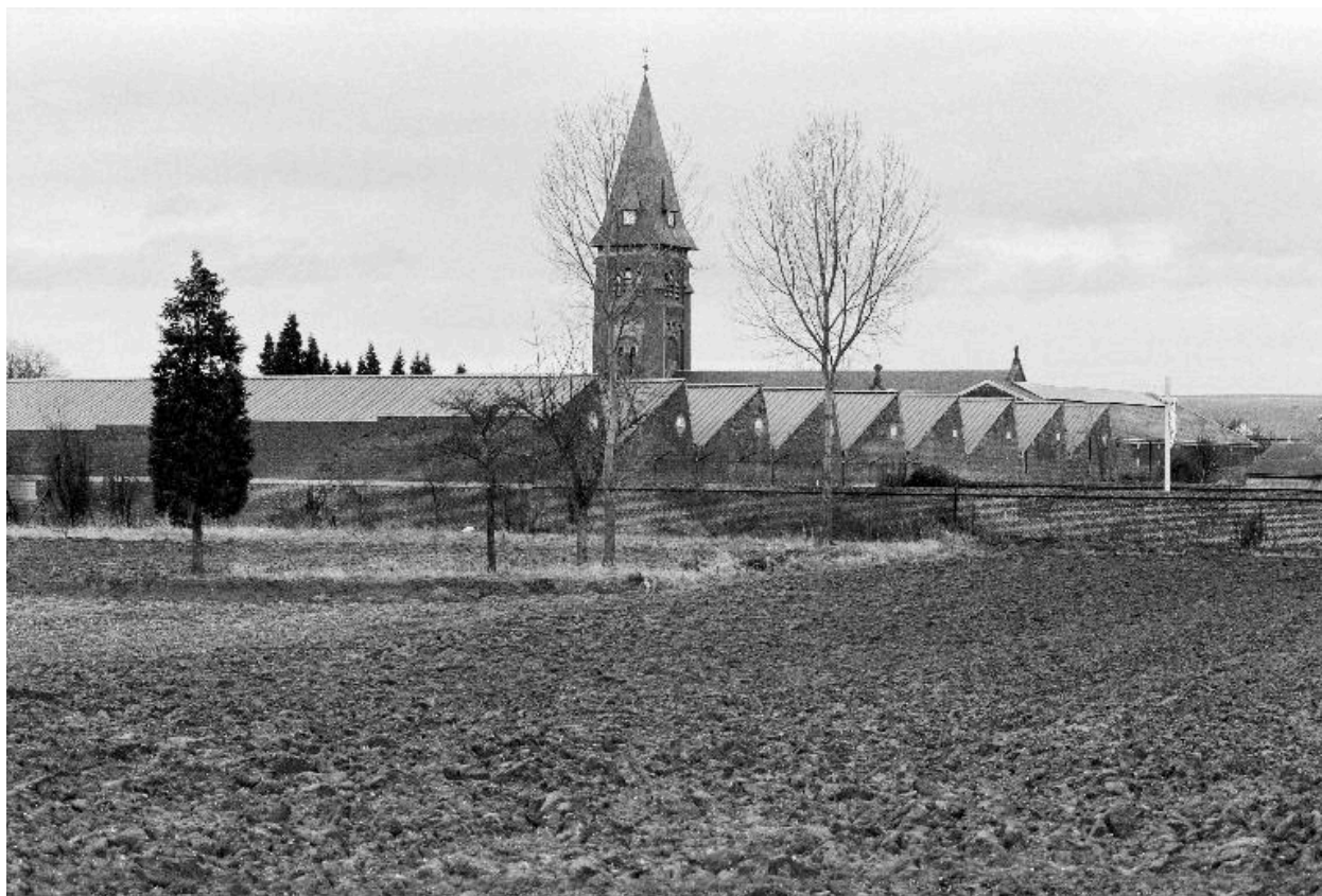
Atelier de fabrication, vue générale.
