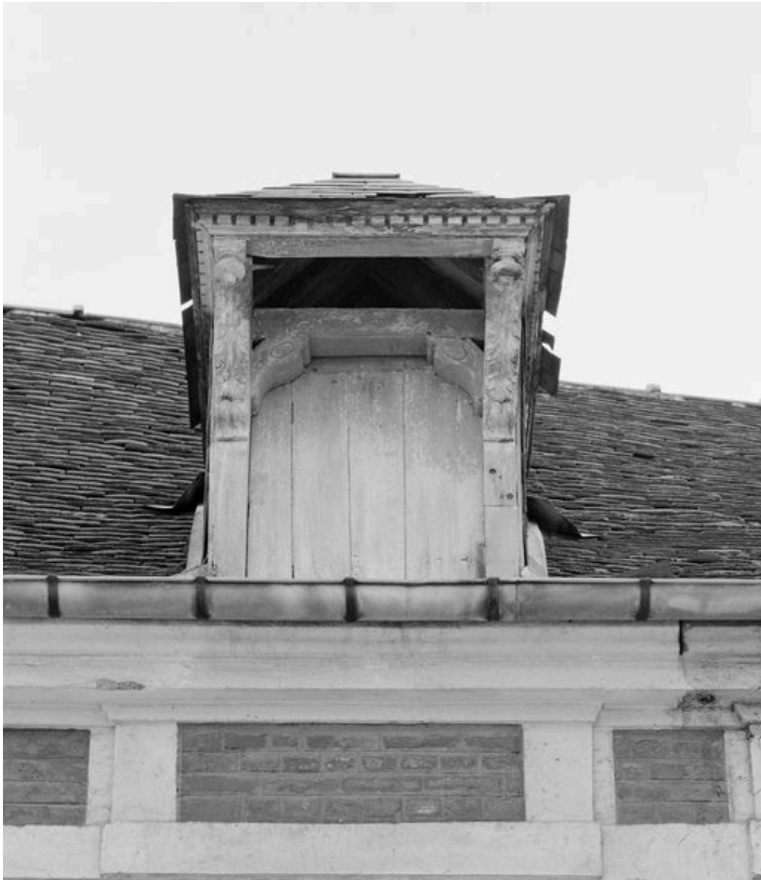
Détail d'une lucarne.
