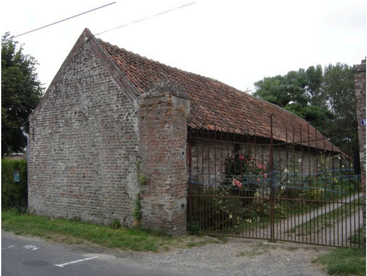
Vue postérieure des dépendances.
