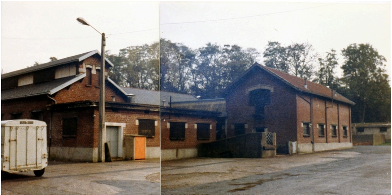
L'abattoir aux porcs, avant démolition en 1985. Photographie Maillot, Maslard, Scalabrini (architectes).
