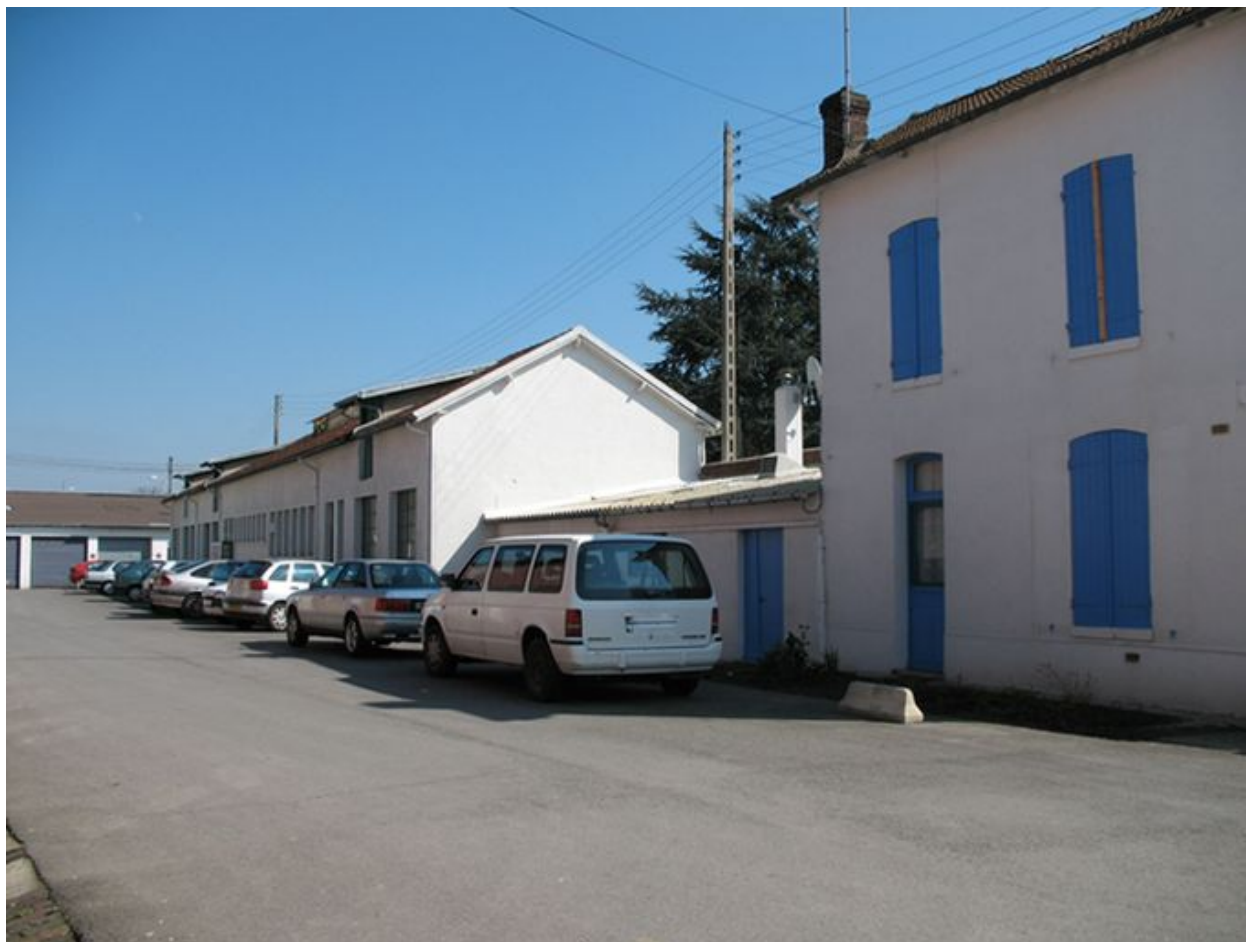
Logement du concierge et ateliers de fabrication le long de la rue Charles-Somasco.
