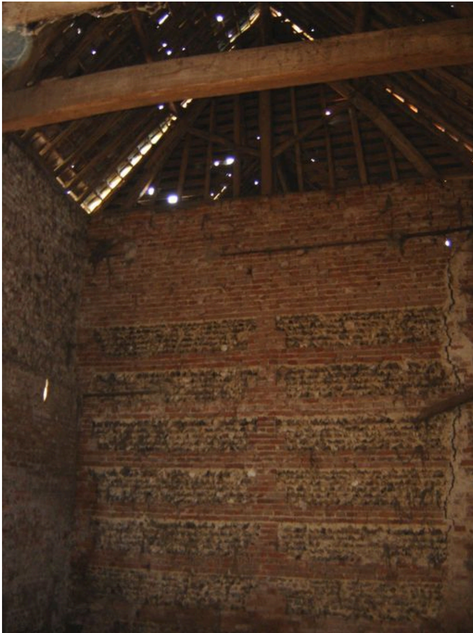
Mur pignon intérieur d'une des deux granges.
