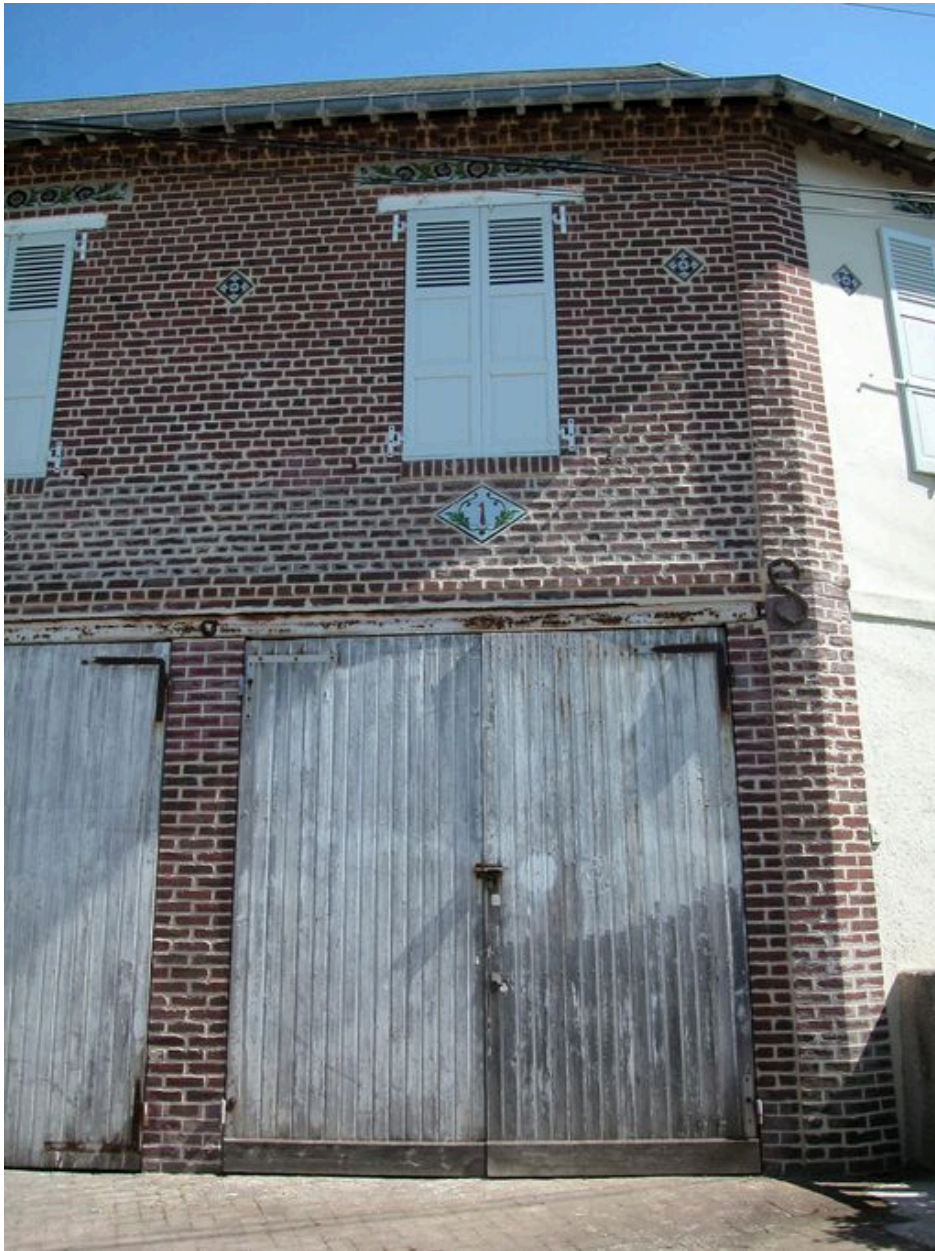
Détail d'une travée avec garage.
