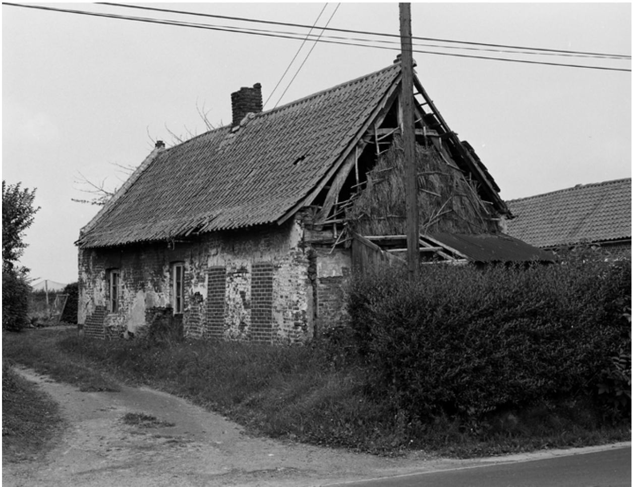
Logis de ferme, rue Morimetz, vue générale.
