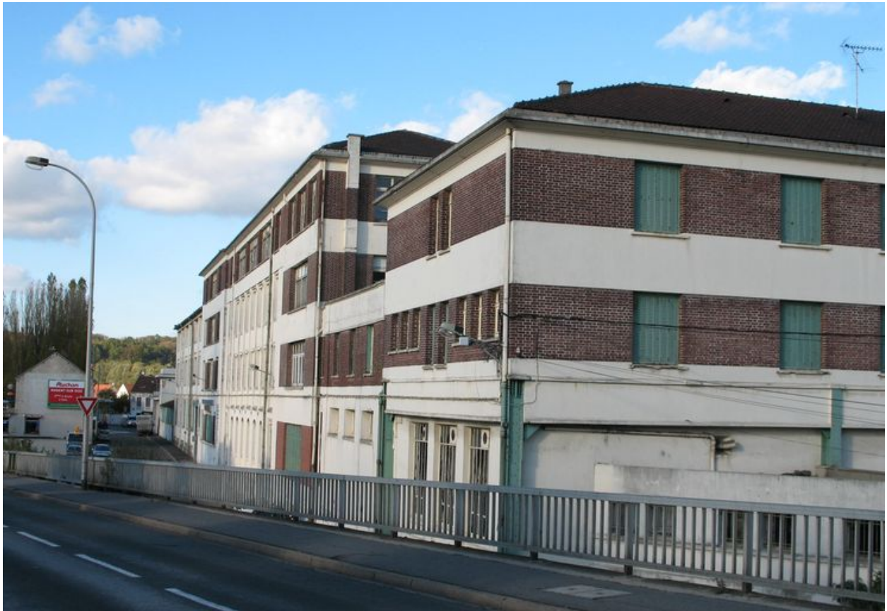
Le front bâti sur l'impasse de Gournay vu vers le nord-ouest
