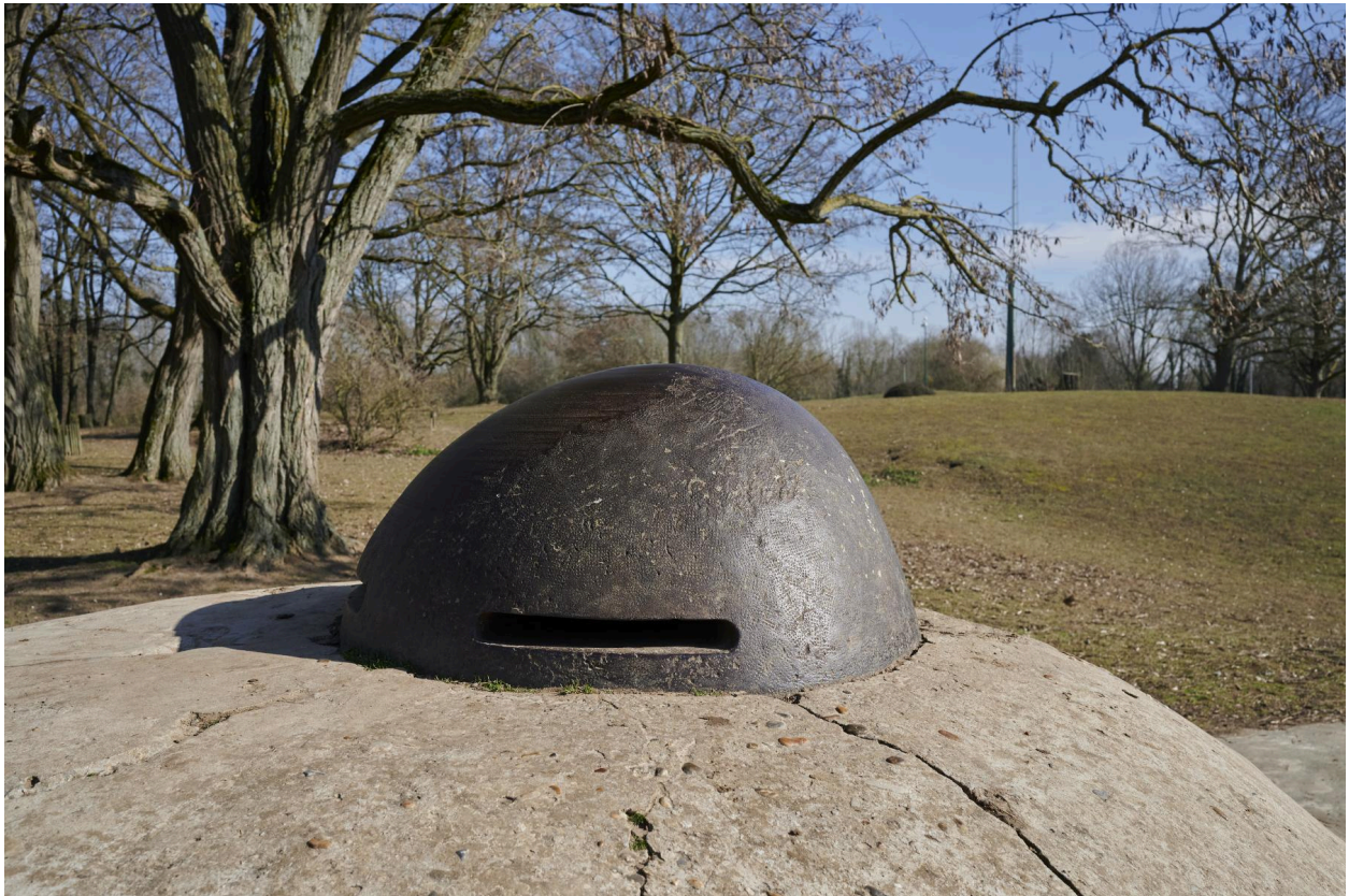
Abri casematé avec observatoire cuirassé. Détail de la coupole vers l'est.
