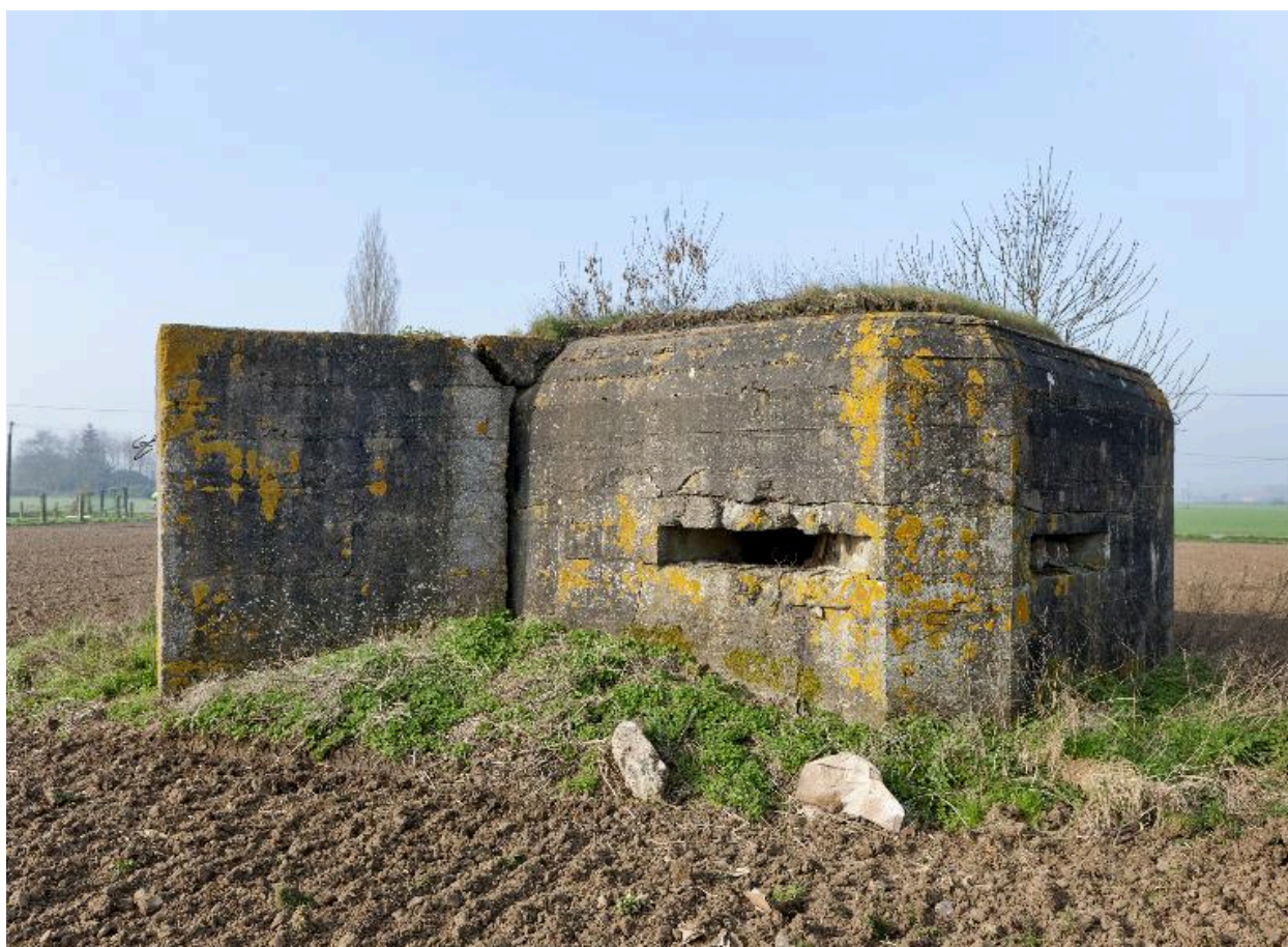
Vue générale, vers le sud-est
