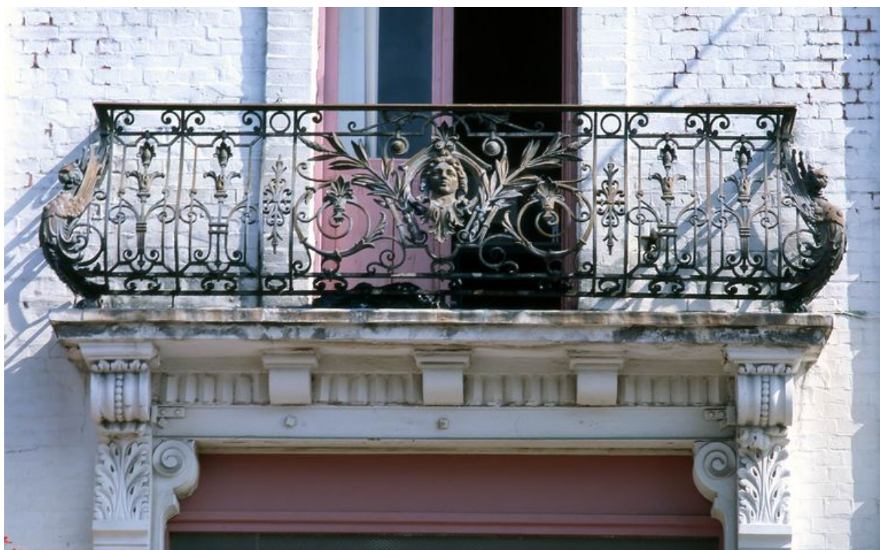
Détail d'un garde-corps en fonte en façade principale.
