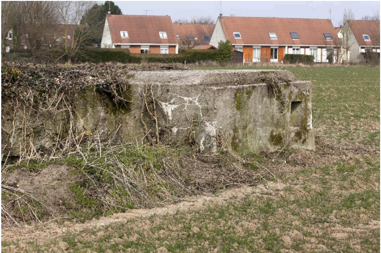
Détail de l'ouvrage en L précédent.
