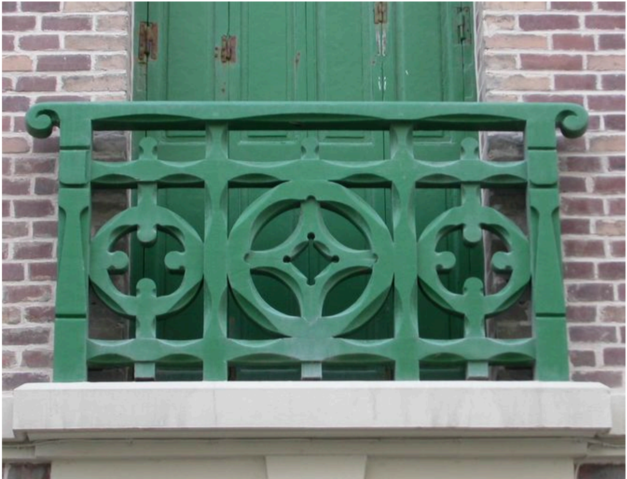
Détail du balcon en menuiserie.
