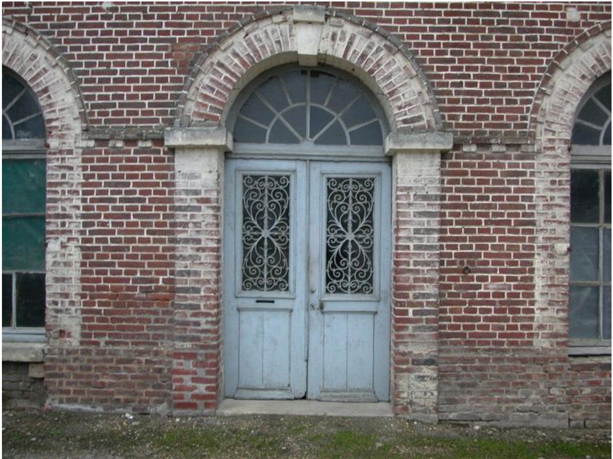
Détail de la porte d'entrée.
