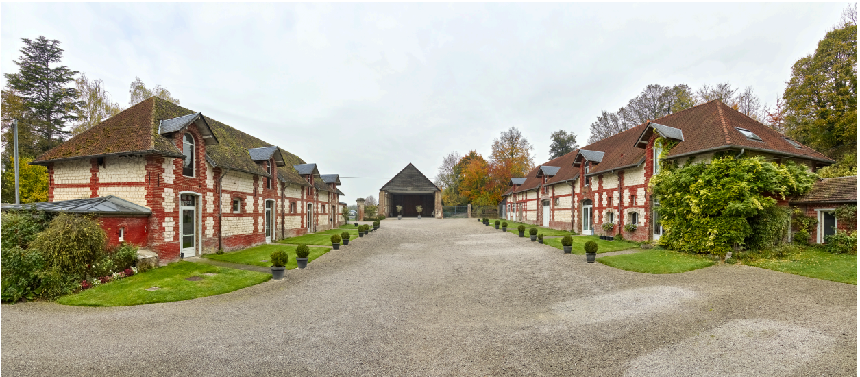
Vue de la cour, depuis l'est.
