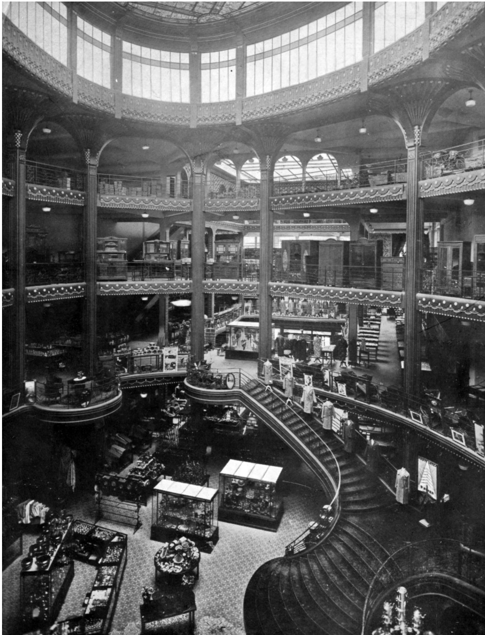
Vue de l'atrium ovale et du grand escalier entre 1927 et 1934 (Cité de l'Architecture et du Patrimoine ; fonds des Bétons armés Hennebique ; 3-D-364-c).
