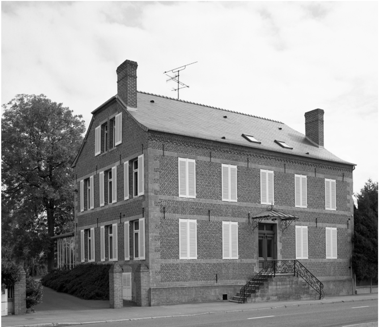
Vue nord de la maison, construite à côté du moulin (détruit).
