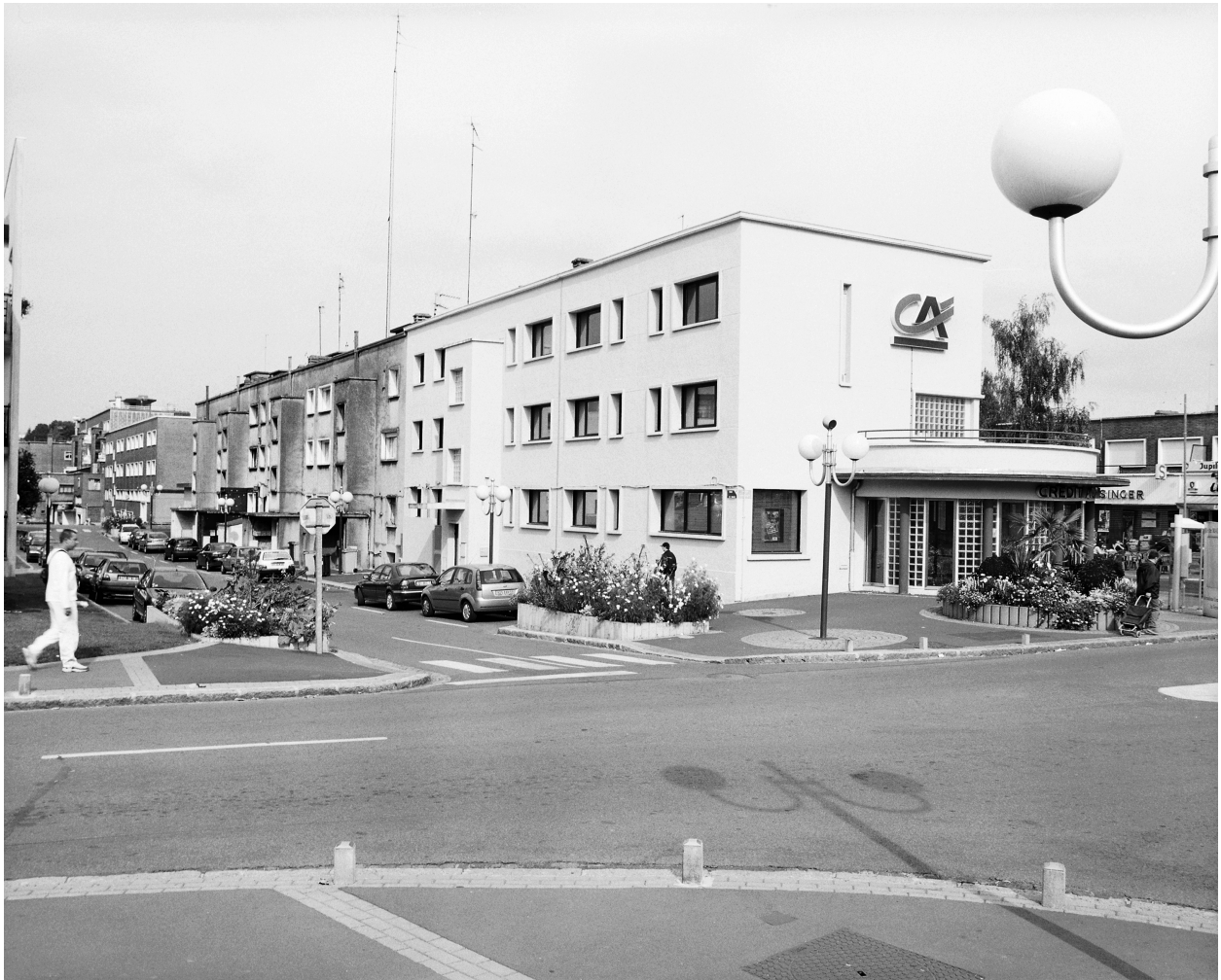
Vue générale de l'îlot M, l'élévation postérieure, rue de la porte de France.
