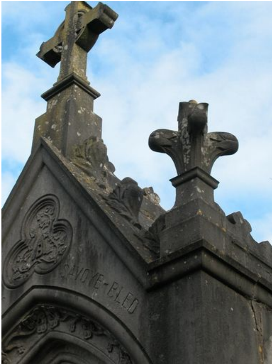
Vue des rampants.
