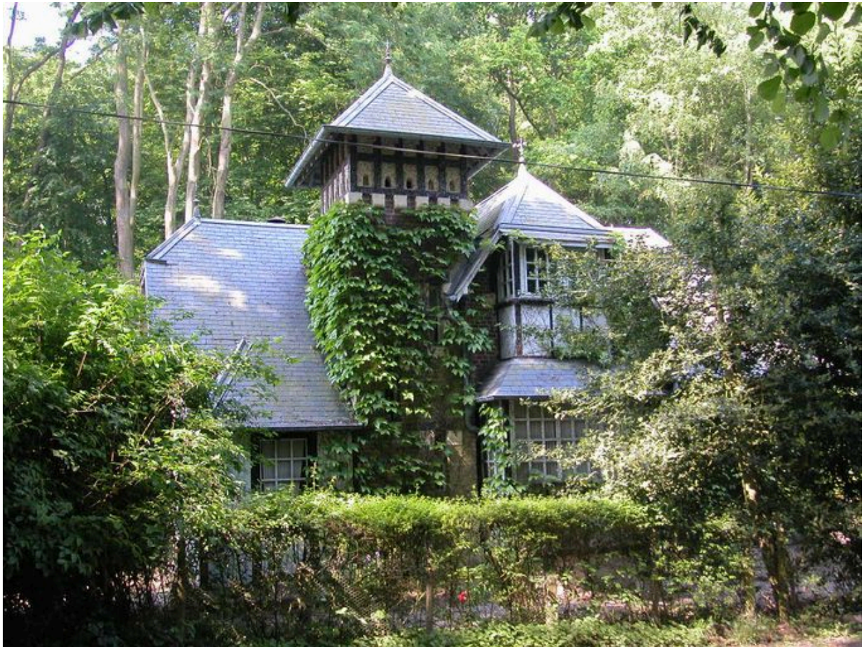
Vue d'ensemble depuis la route du Vieux-Chêne.
