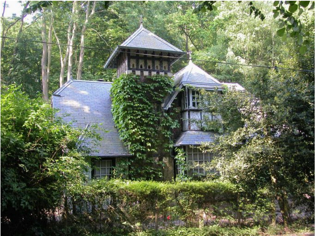
Vue d'ensemble depuis la route du Vieux-Chêne.
